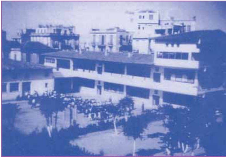
Τα διδακτήρια του ΠΣΠΘ πριν την ολοκλήρωσή τους.
